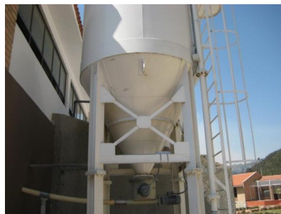
Imagen 2.32: Transportador de tornillo en la industria del agua (Dosificador de Cal).
