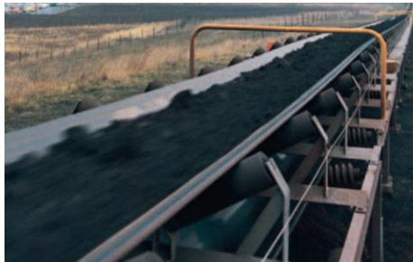
Imagen 2.14: Transportador de banda en canal.
