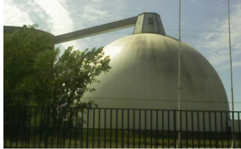
Imagen 2.47: Silo de Bunker.
