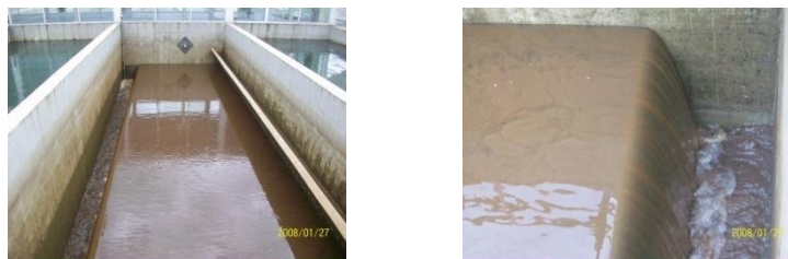
Fotografía 1.5: Lavado de la unidad de filtración.
