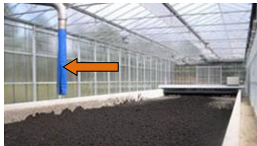
Imagen 2.41: Ingreso de lodo por tornillo helicoidal.
