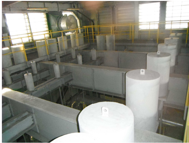
Obr. 16 Uchycení fluidního kotle K6 shora
