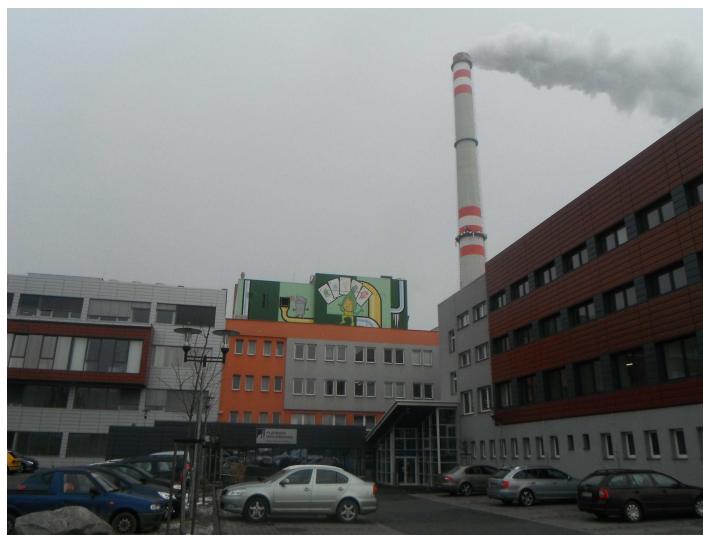
Obr. 5 Plzeňská teplárenská, a.s.
