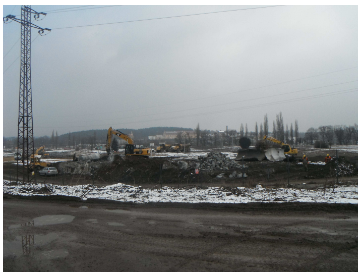
Obr. 44 Areál čistírny odpadních vod města Plzně
