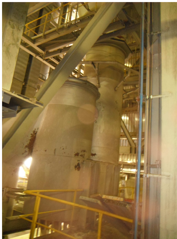
Obr. 15 Fluidní kotel K6
