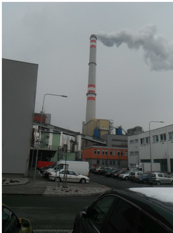
Obr. 11 Plzeňská teplárenská, a.s.
