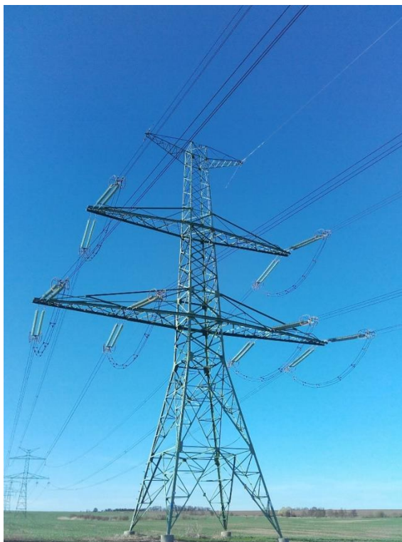
Obr. 2.4 Kotevní stožár Donau osazený trojsvazkem [4]
