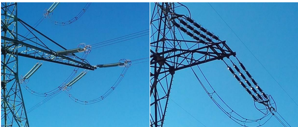
Obr. 2.5 Zavěšení svazkových vodičů [4]
