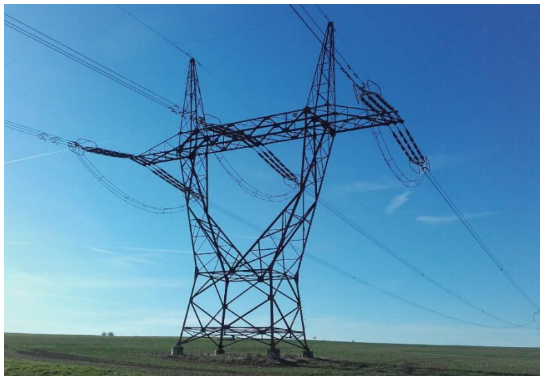
Obr. 2.1 Kotevní stožár Kočka osazený trojsvazkem [4]
