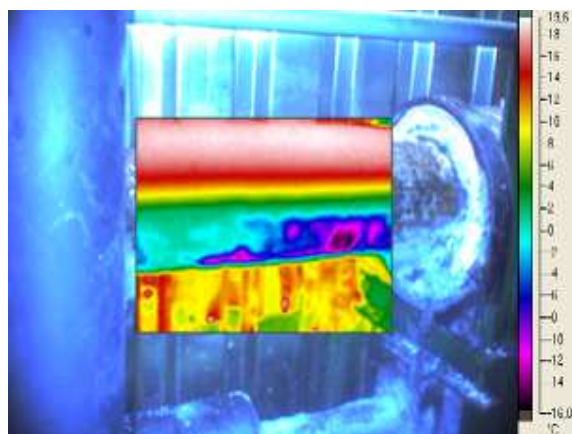
Obr. 11.5 NH 3 v potrubí
