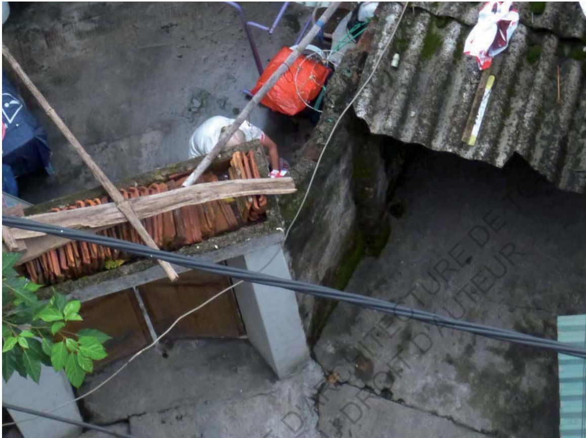
Privatisation d'une ruelle par un enclos maçonné, allé 158 Ngoc Ha . Photo par Arnaud Jouanchicot.
