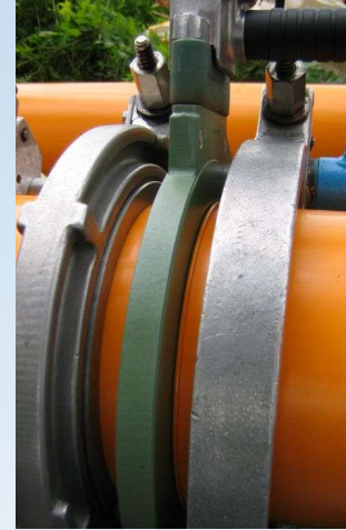
Aufbau der Angleichdrucks und Angleichen der Rohrenden am Schweißspiegel
