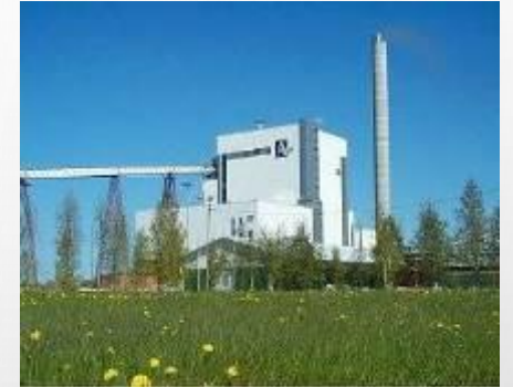
Combustion Power Plant (240 MWe), Alholmens, Φιλανδία
