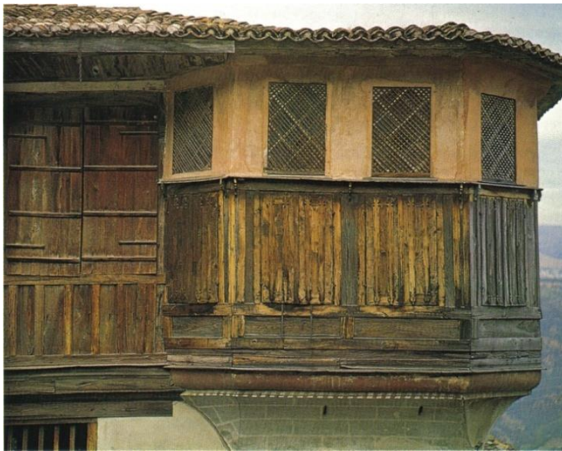
Καφασωτά και καρφωτά σκούρα στο Αρχοντικό του Γεωργίου Σβάρτς στα Αμπελάκια Θεσσαλίας.
