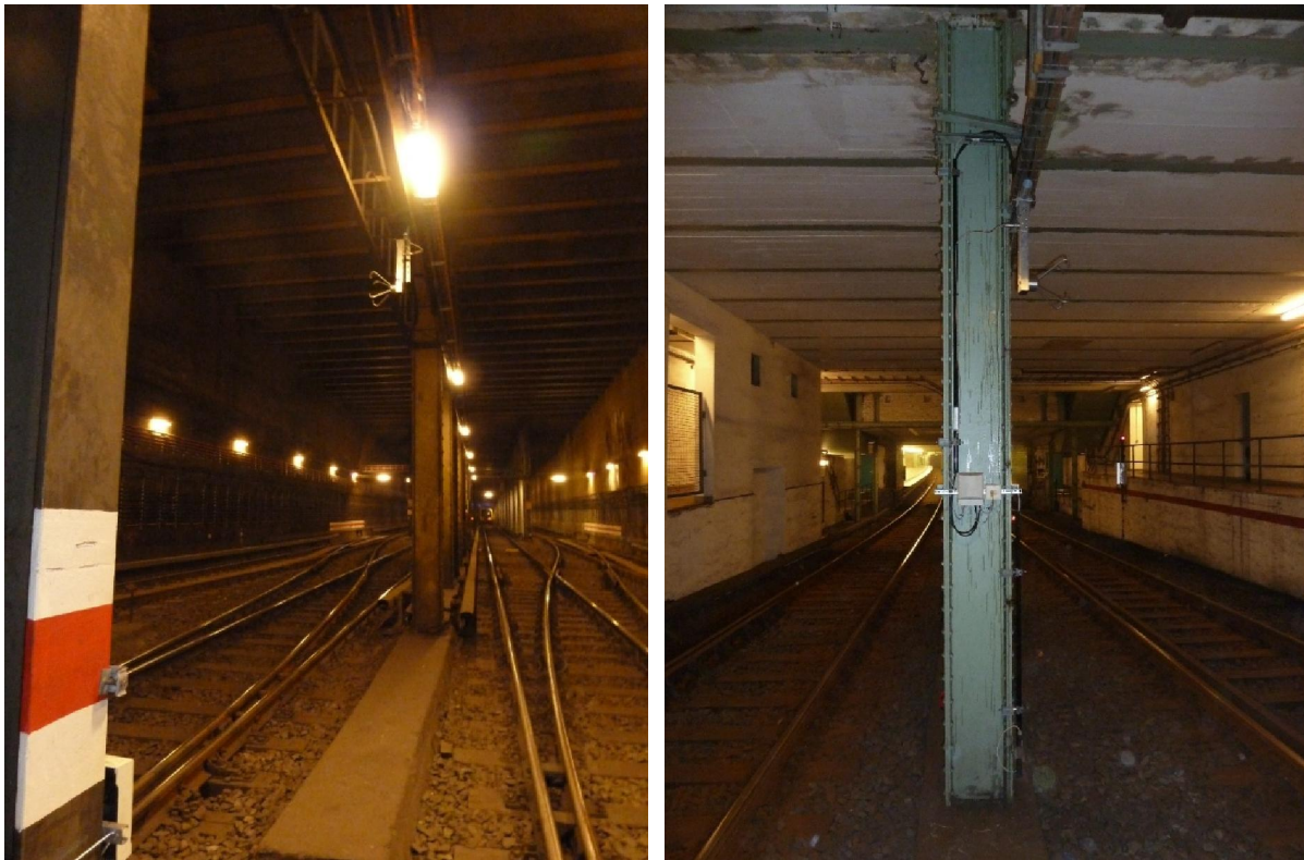
Abb. 1.21: Links: Messpunkt ALU5bh (Blickrichtung von der Station in den Tunnel), rechts: Messpunkt ALU5si (Blickrichtung vom Tunnel in die Station) (Messpunkte siehe Abb. 1.19 , Bildquelle: RUB)
