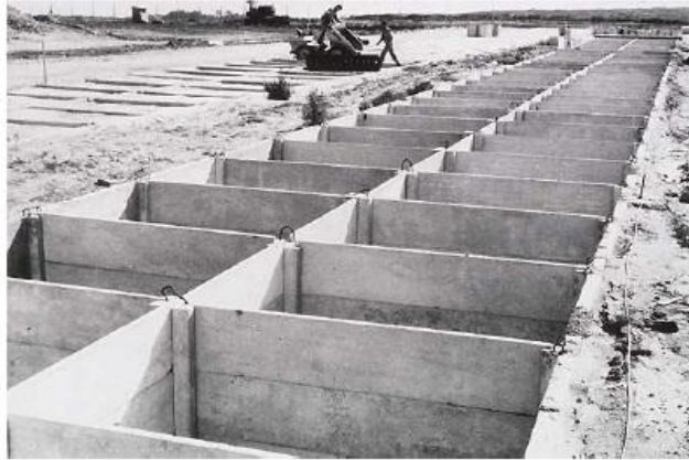
Stockage en tranchées bétonnées
