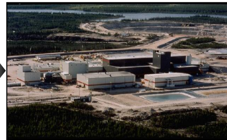
Usine de concentration du minerai (Proche de la Mine)
