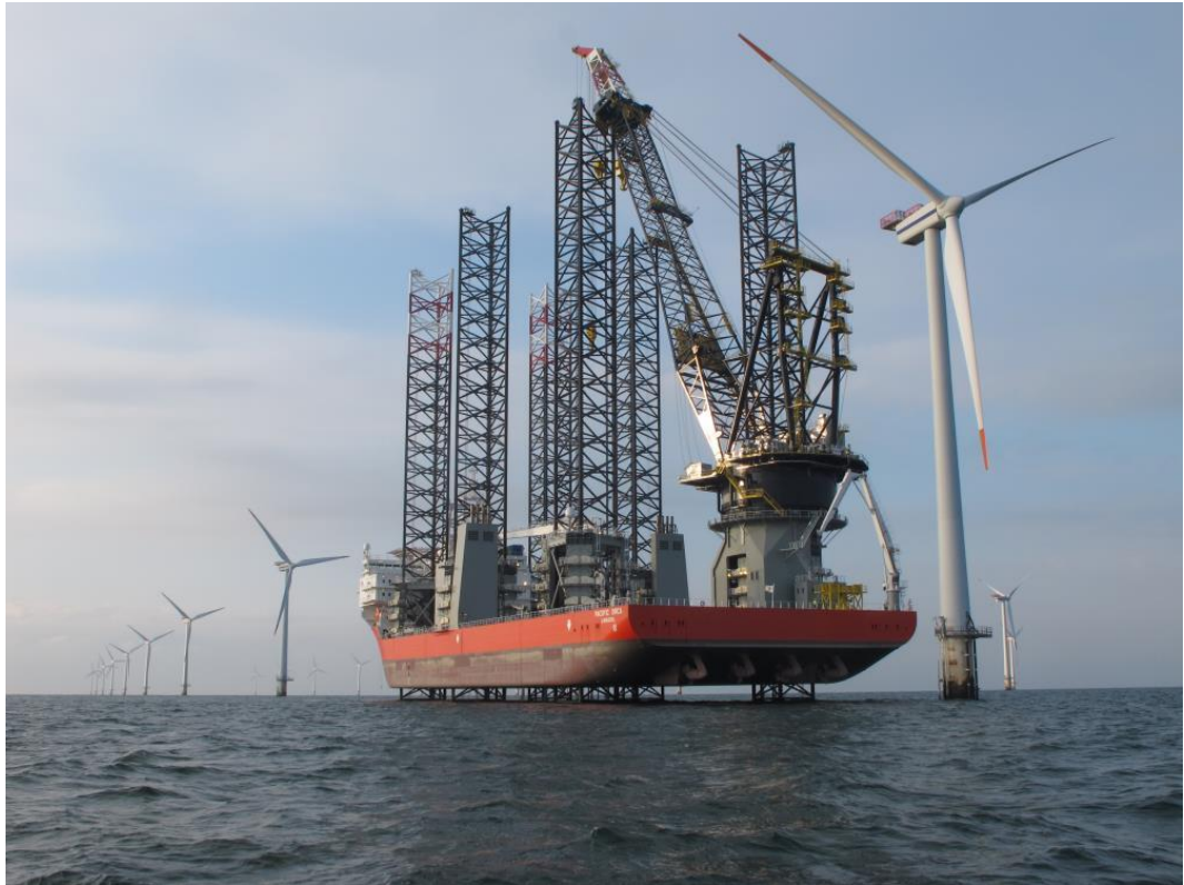
Figur 10-10. Installation af havmøller med jack-upfartøj (Foto: Swire Blue Ocean).
