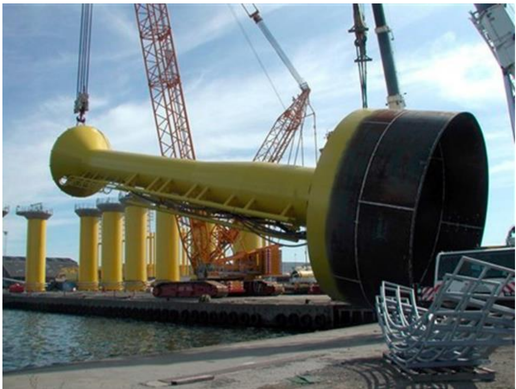
Figur 10-7. Sugebøttefundament (Foto: Aalborg Universitet/Scanpix).
