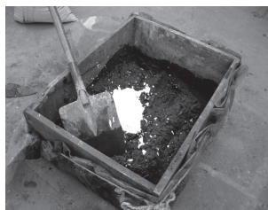
Figura 6. Mezcla de lodo con cal.
