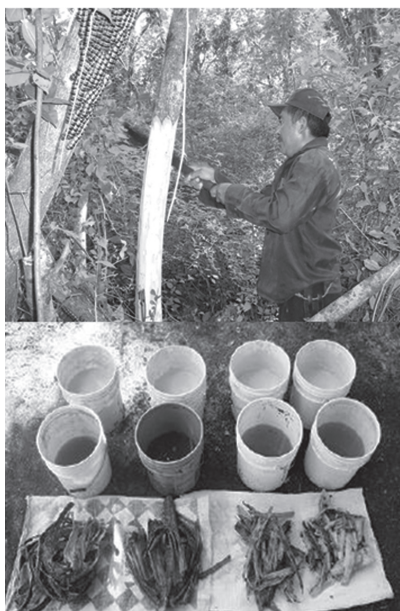
Figura 4. Preparación de morteros con aditivos orgánicos de árboles de la región con ayuda de la experiencia de los trabajadores locales.
