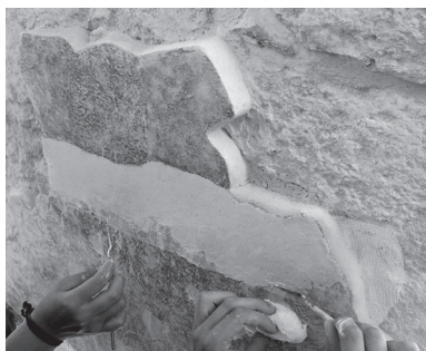
Figura 6. Aplicación de réplica sobre aplanado rojo ubicado en la pilastra frente al cuatro 23.
