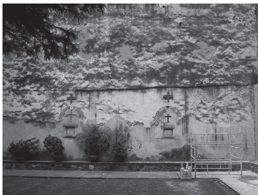
Figura 8. Muro sur del exconvento de Churubusco antes del proceso.
