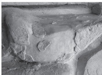
Figura 5. Resane de faltante de relieve de estuco hecho a un nivel ligeramente más bajo que el original.
