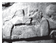
Detalle, pérdida del relieve.
