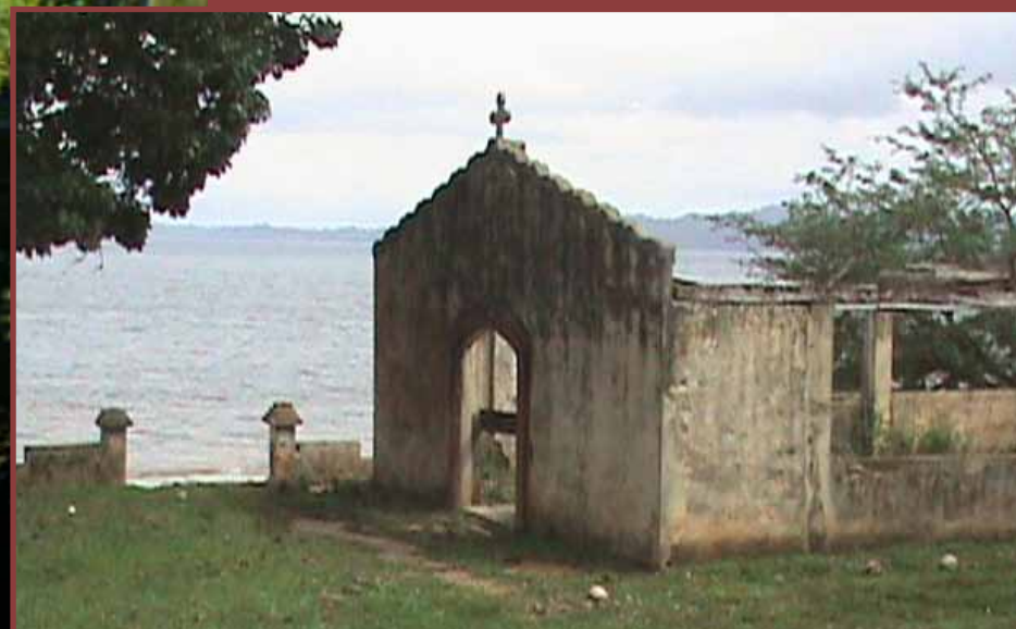
Iglesia Católica del campamento Central, Isla Coiba. Foto: Darío Tovar
