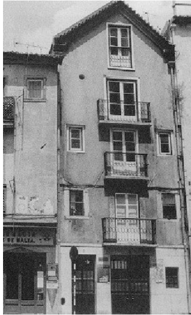
Figura 2.2 - Edifício pré-Pombalino com uma fachada de bico (Santos, 2013)
