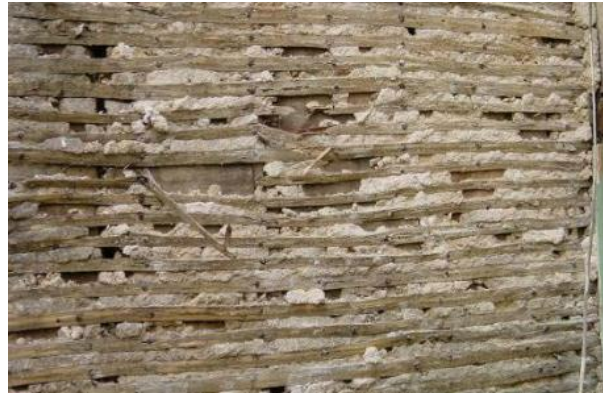
Figura 2.5 - Exemplo de uma parede de tabique
