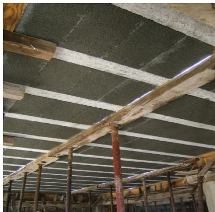
Figura 2.17. Execução de tarugos, numa solução de pavimento de laje de vigotas pré-tensionadas com blocos de betão leve.
