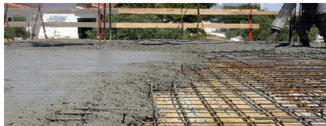
Figura 2.10. Betonagem de uma laje maciça.
