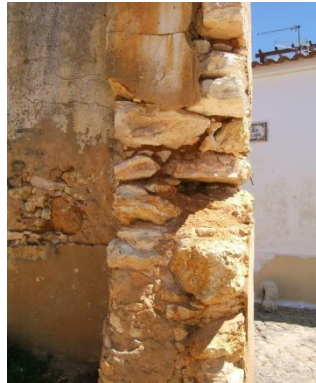
Figura 2.8. Alvenaria de pedra de duas folhas.
