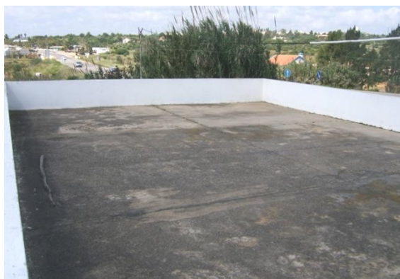
Figura 2.18. Cobertura executada em laje de terraço.
