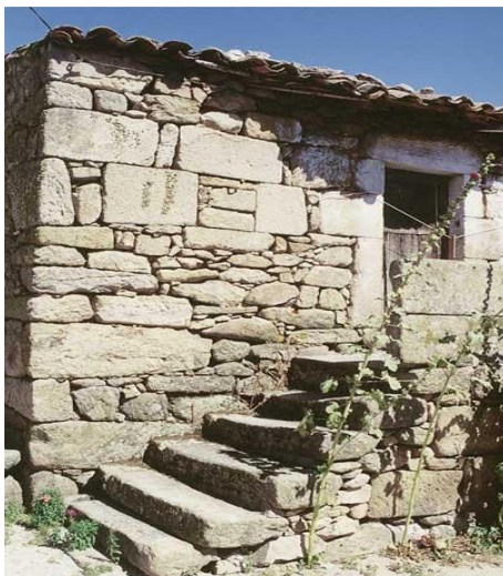
Figura 2.7 a) Alvenaria de granito (região Norte)
