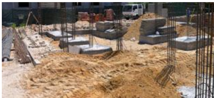
Figura 2.15. Fundações executadas através de sapatas isoladas.
