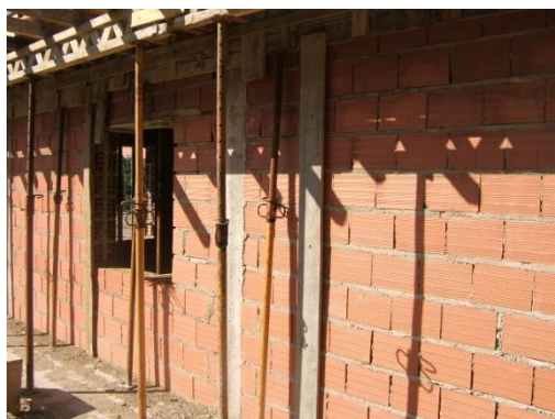
Figura 2.19 c) Parede de alvenaria de tijolo.
