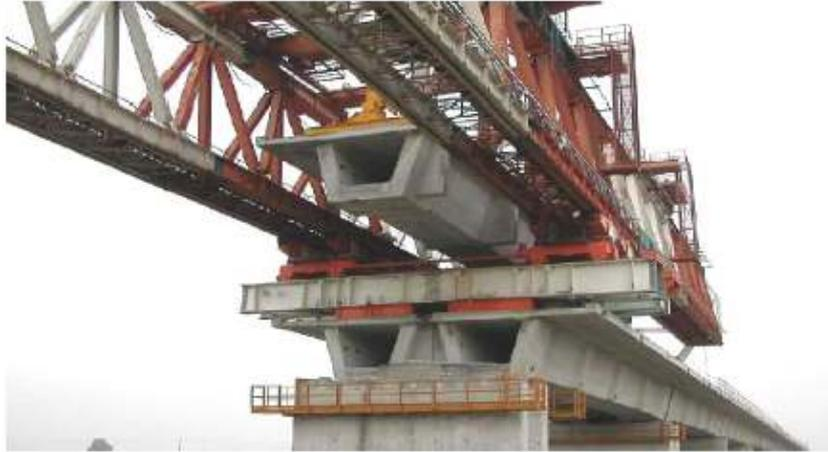
Figura 9 - Montagem de um tabuleiro constituído duas vigas caixão pré-fabricadas [1]
