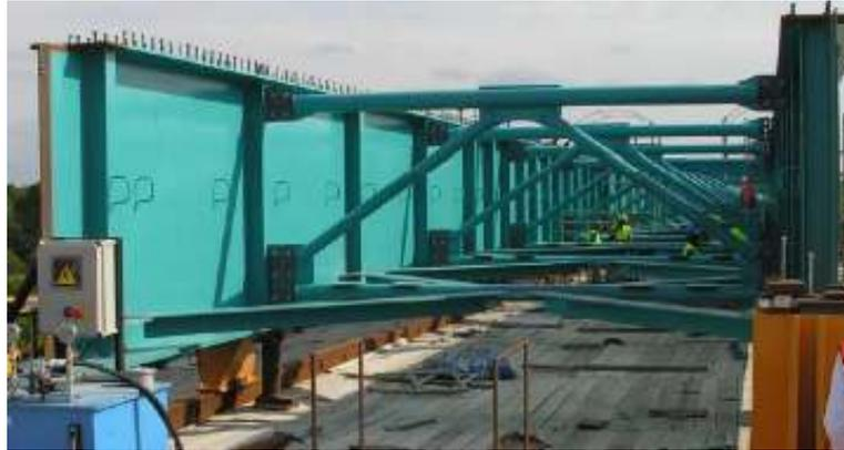
Figura 7 – Montagem do tabuleiro misto bi-viga (Viaduto Norte, Alcácer do Sal) [13]
