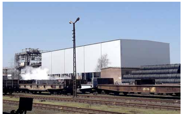
Neue Einhausung für Kippprozess und Abkühlung E-Ofenschlacke
