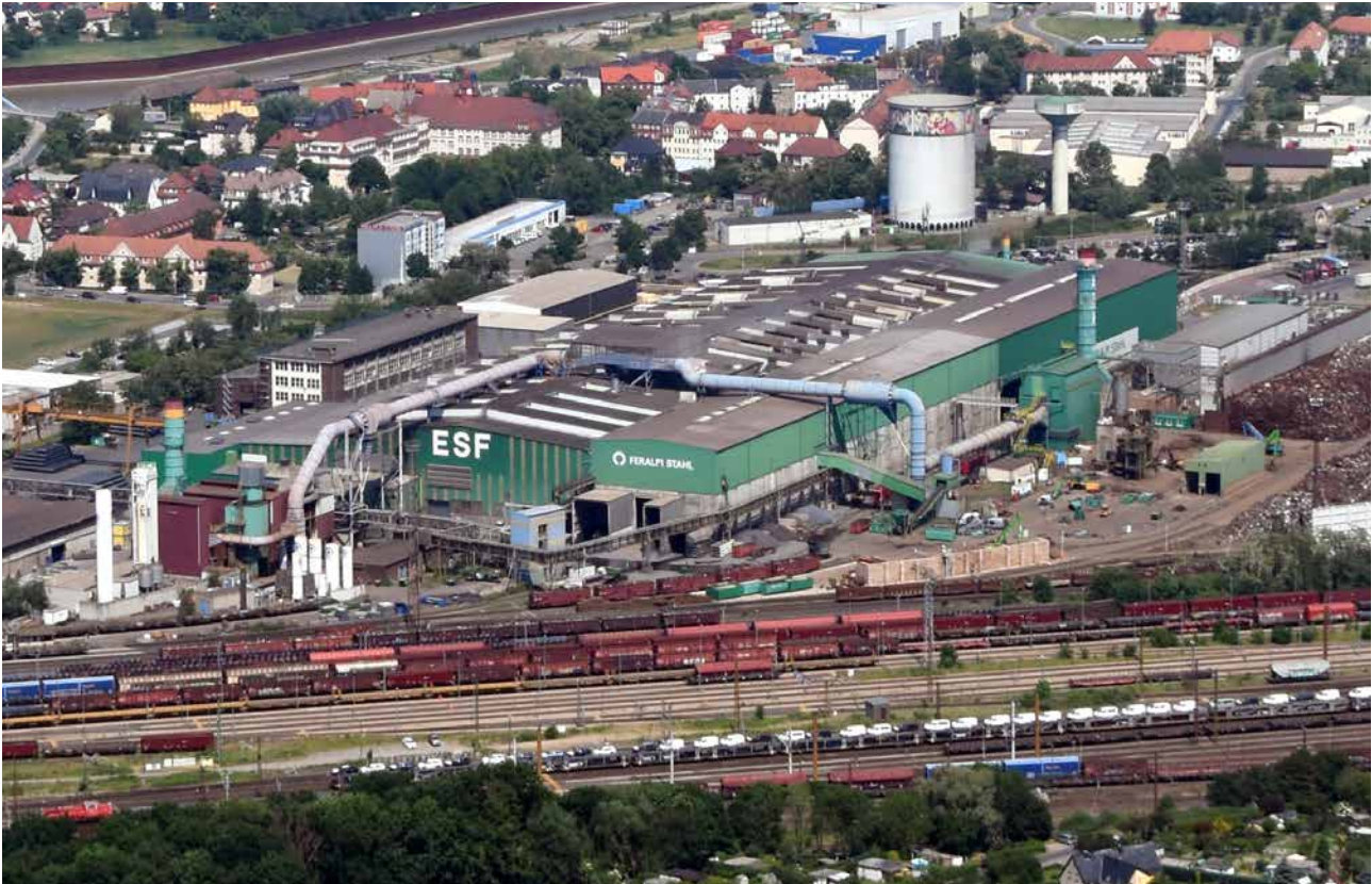
Das hochmoderne Entstaubungssystem des Elektrostahlwerkes der ESF 2021
