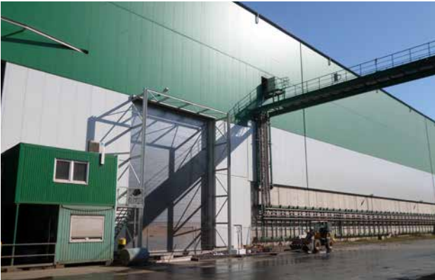
Weitere Schließung der Schrotthalle, Südseite (seit 2015)
