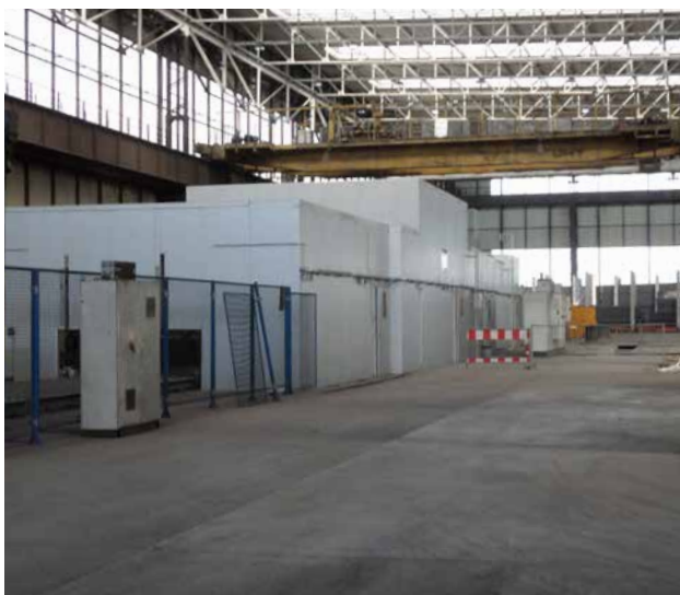
Kapselung Mattenschweißmaschine, Mattenhalle (seit 2015)
