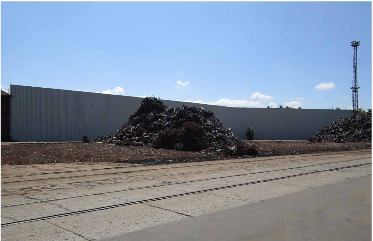
Errichtete Schallschutzwand am Schrottlager 4/5 (2016)
