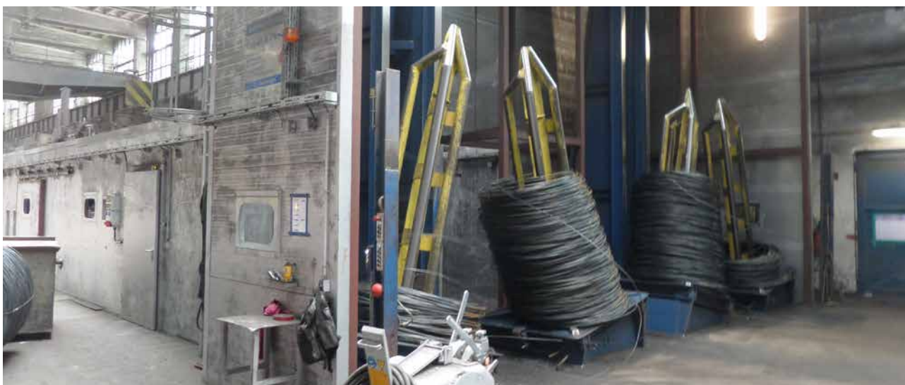
Kapselung der Drahtzuganlagen, Mattenhalle (seit 2015)
