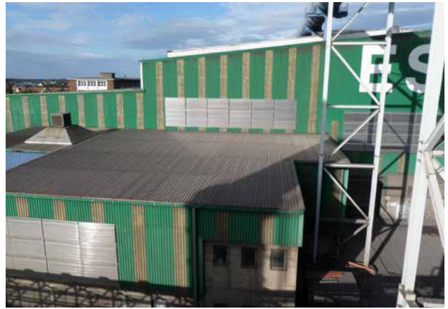
Austausch und Einbau von Zu- und Ablüftern im Dachbereich sowie in den Ost- und Westgiebel des Stahl- und Walzwerkes (seit 2014)
