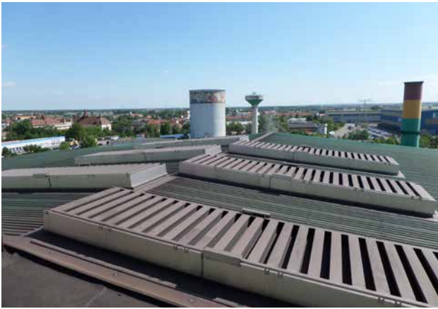
Austausch und Einbau von Zu- und Ablüftern im Dachbereich sowie in den Ost- und Westgiebel des Stahl- und Walzwerkes (seit 2014)
