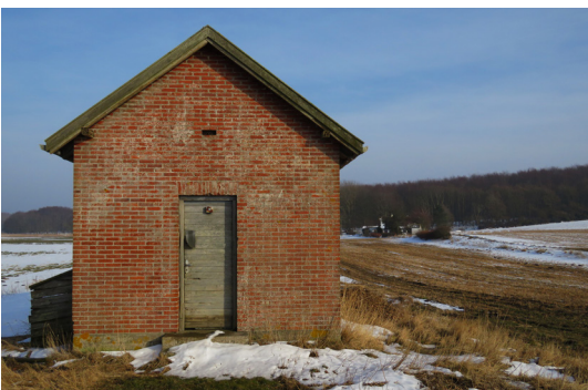
Et typisk pumpehus syd for Korsebøllevej.
