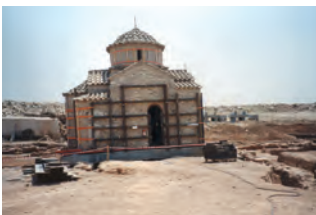
Ο ναός κατά τη διάρκεια της μεταφοράς του The church in course of its transfer
