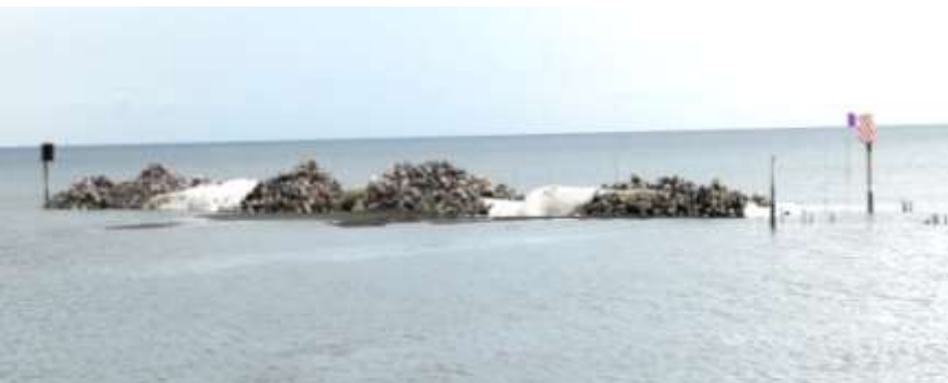
ภาพที่ 4.7 ลักษณะการปรับเปลี่ยนพื้นที่ปากแม่น้ำและบริเวณชายฝั่งที่ทำให้เกิดผลกระทบต่อระบบนิเวศทางน้ำ (ภาพบน; การใช้ดินลูกรังถมพื้นที่ป่าชายเลน ในเขตอำเภอปากน้ำหลังสวน จังหวัดชุมพร, ภาพกลาง; การใช้หินก้อนขนาดใหญ่ถมแนวชายหาด ในเขตอำเภอสามร้อยยอด จังหวัดประจวบคีรีขันธ์, ภาพล่าง; การใช้หินและกระสอบบรรจุทรายวางเป็นแนวกันคลื่น ในพื้นที่ใกล้ชายฝั่ง ตำบลกาหลง จังหวัดสมุทรสาคร)
