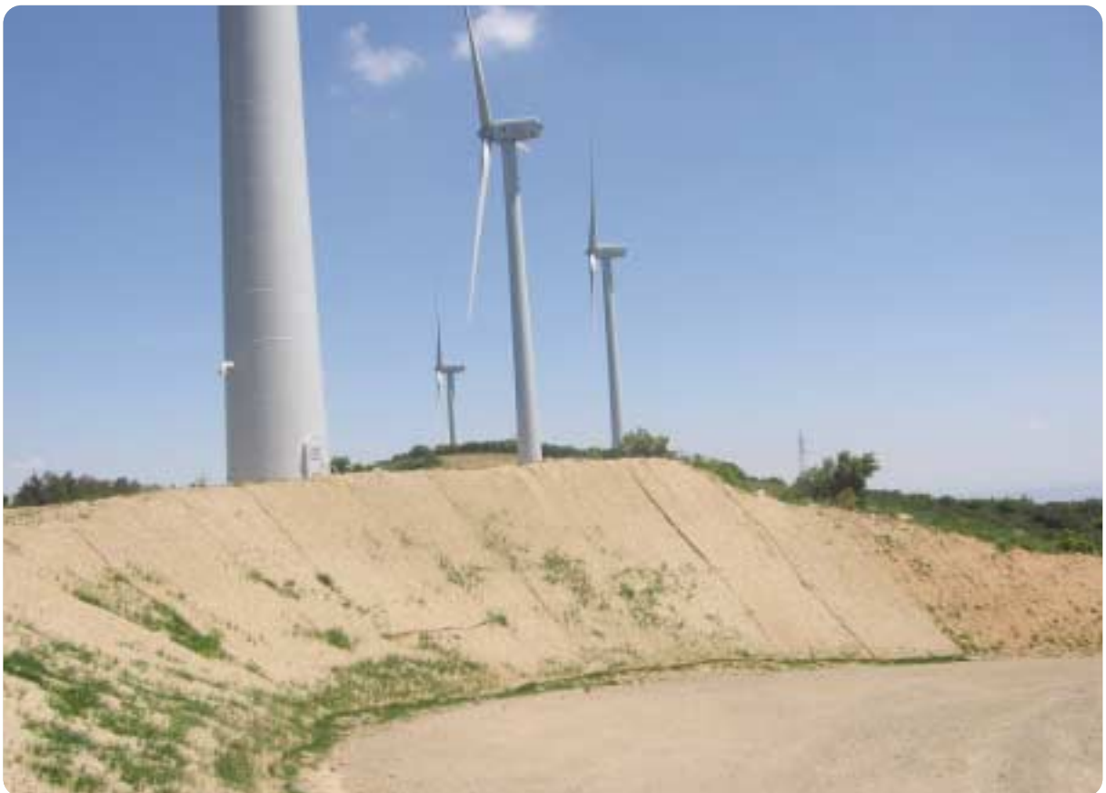
Revegetación temprana con geotextil en Gatún (La Rioja)
