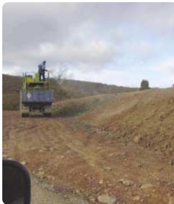
Hidrosiembra en talud de pista (La Rioja)
