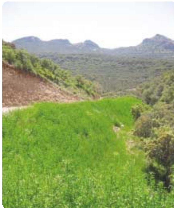
Revegetación en talud
