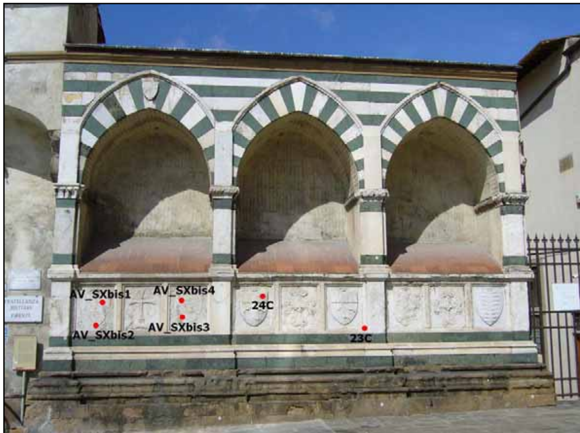
Fig. 3.1 b – Punti di campionamento in corrispondenza degli Avelli a sinistra della facciata della chiesa di Santa Maria Novella.
