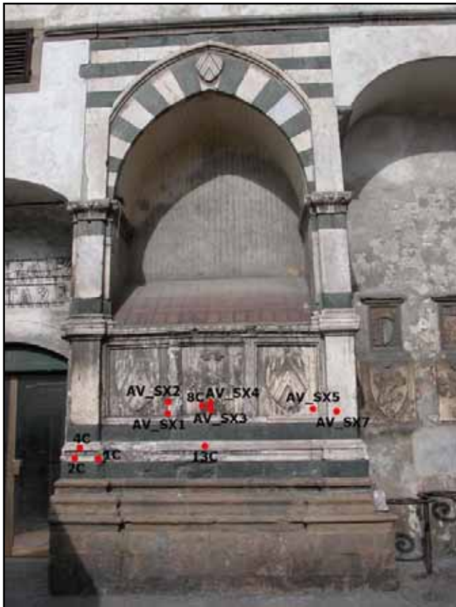
Fig. 3.1 a – Punti di campionamento in corrispondenza dell'Avello a sinistra della facciata della chiesa di Santa Maria Novella.
