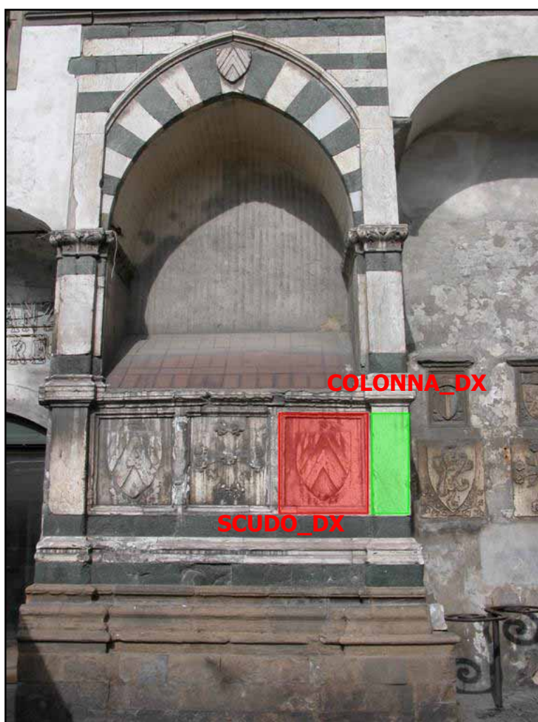
Fig. 3.30 – Aree indagate mediante Fieldspec Pro in corrispondenza dell’Avello a sinistra della facciata della chiesa di Santa Maria Novella.
