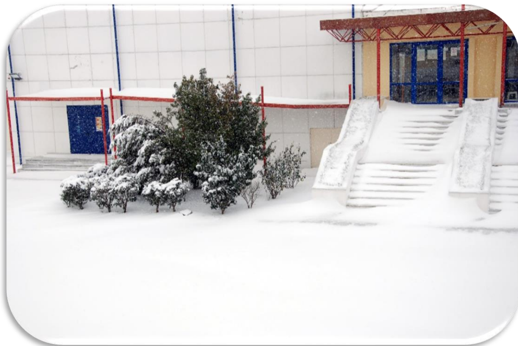
Εξωτερικός Χώρος της Σχολής
