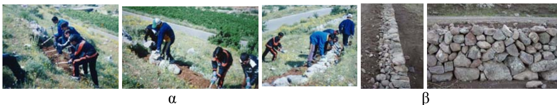
Εικόνα 10α,β. Ανακατασκευή ξηρολιθινών βαθμιδών α) σε περιοχή εγγύς της αρχαίας Τίρυνθας, από μαθητές του Γυμνασίου Προσύμνας και β) στην Κλειώ Λέσβου.
