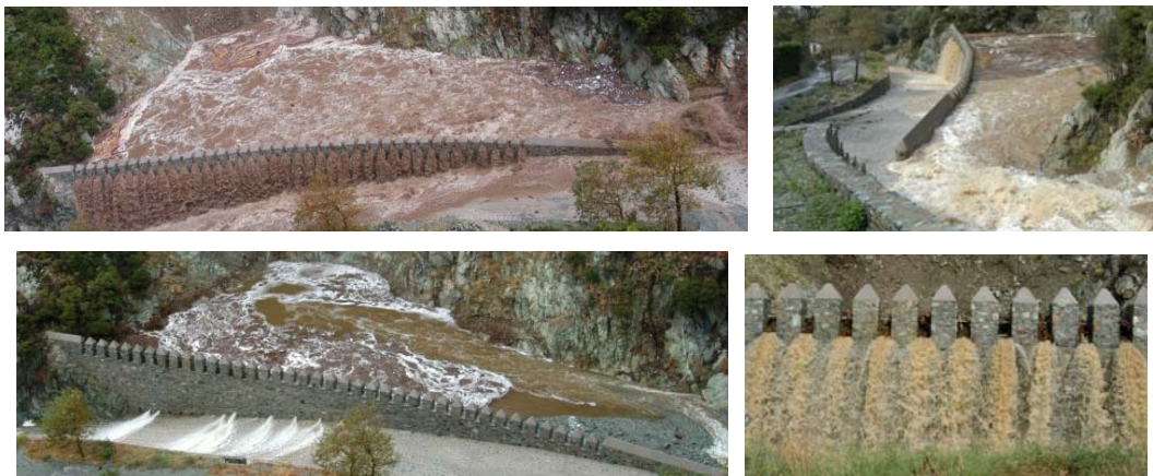
Εικόνα 13α,β. α) Απόψεις του συνόλου των έργων του συστήματος διευθέτησης του χειμάρρου Αεροπόταμος της Ι. Μ. Αγίου Διονυσίου Αγίου Όρους (Σχ. 2, Παυλίδης 2012β). Στη διευθέτηση εντάσσεται το σύνολο των εντός και εκτός κοίτης έργων και β) άποψη μέρους των έργων σε πλημμυρική λειτουργία, μετά την κατασκευή του συνόλου των έργων διευθέτησης.
