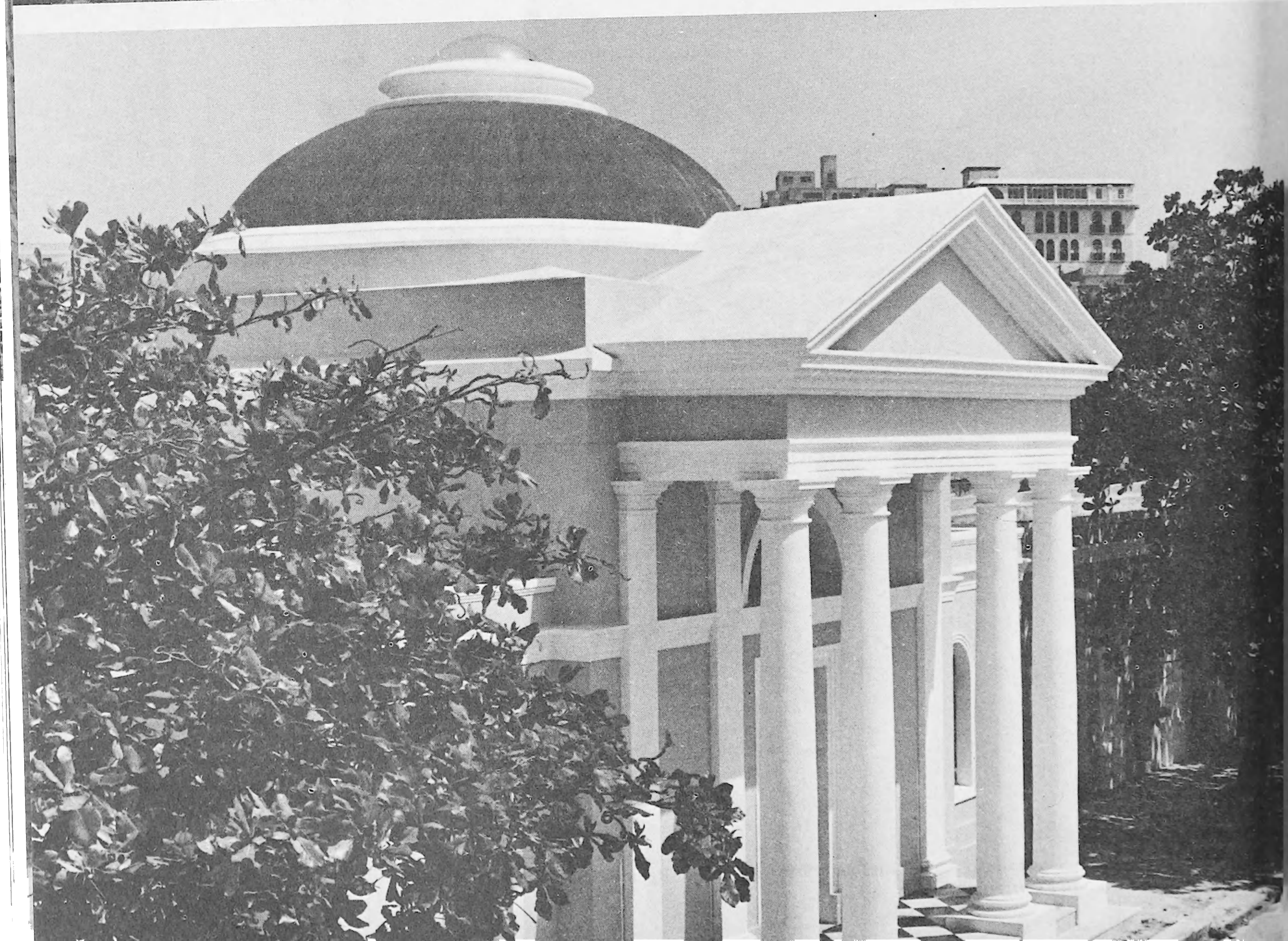
Zona Historica de San Juan (Capilla del Arsenal), San Juan, Puerto Rico. HABS. Instituto de Cultura Puertorriquena
