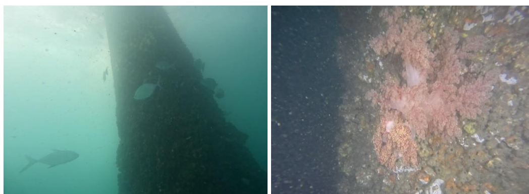
圖 2.1.6-2 D07 基樁表面生長藤壺、珊瑚照
