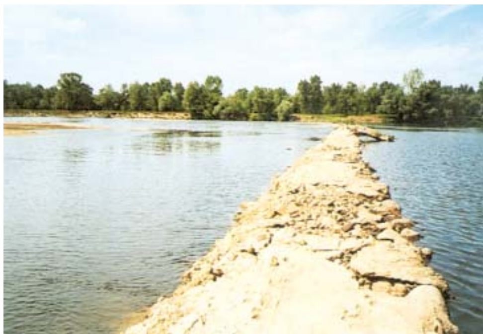
Fot. 20. Nowowymbudowana ostroga w korycie Wisły k. Wyszogrodu (ok. 300 m długości), która likwiduje izolację od brzegu Kępy Wyszogrodzkiej – projektowanego rezerwatu ptaków
