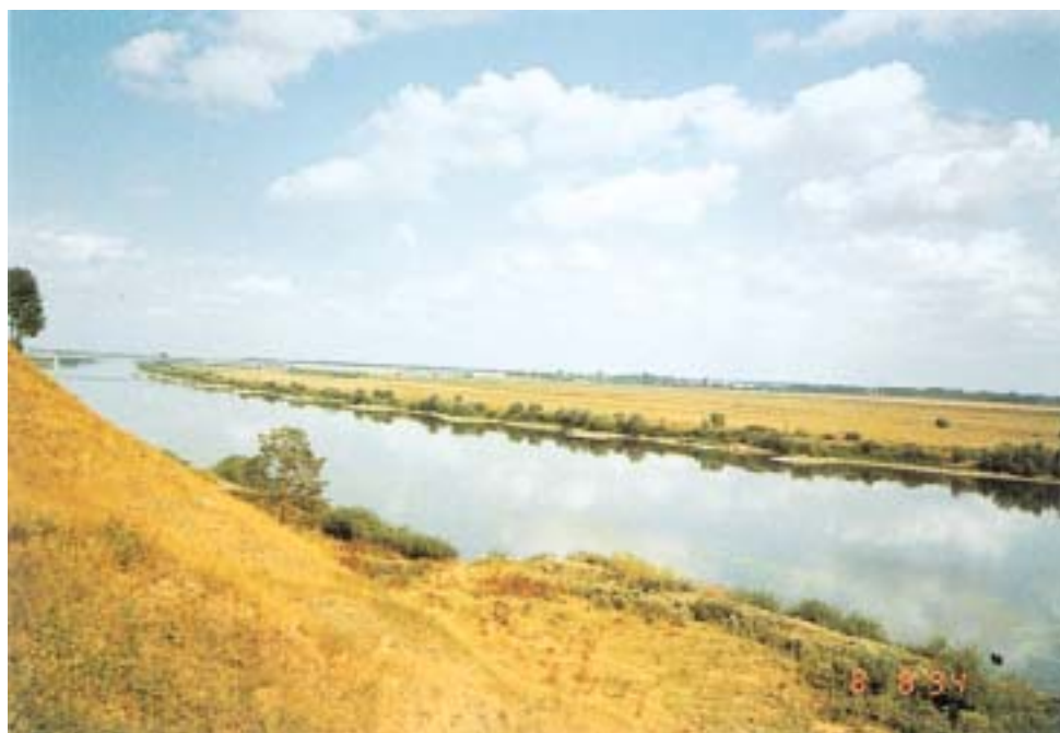
Fot. 8. Uregulowane koryto Wisły w rejonie Tczewa
