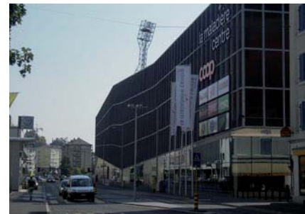
Centre de la Maladière (NE) : Beispiel einer integrierten Ansiedlung mit gutem Angebotsmix und gelungener Ausgestaltung der Aussenräume.
