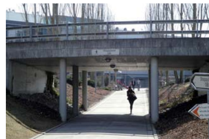
Shopyland Schönbühl (BE) Eine angenehme Allee führt direkt von der S-Bahn-Haltestelle zum Zentrumseingang.
