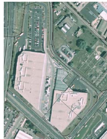
Ebene der Parzelle: Positionierung der Eingänge, Lage der Parkplätze, Beziehung zur nahen Umgebung (Beispiel: Léman Centre Crissier/VD).
