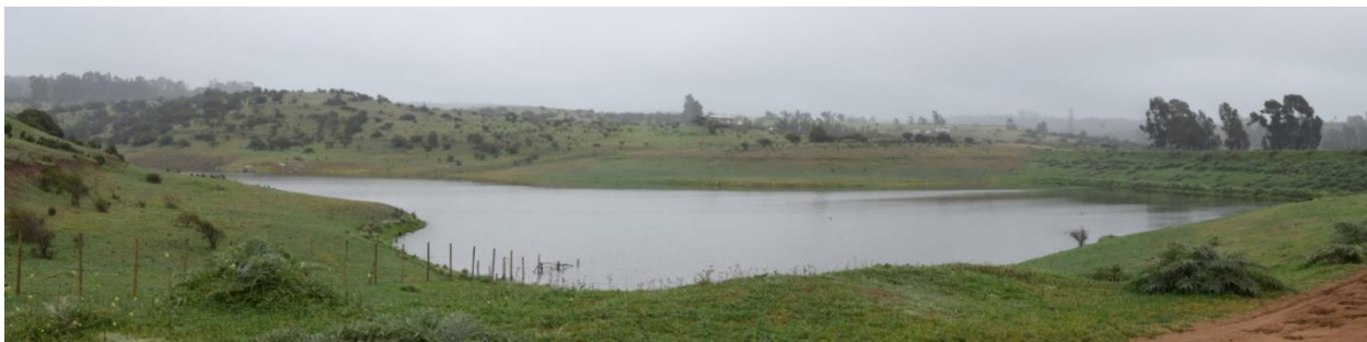
Figura 3. Tranque 1 Interior Fundo Quintero. Fotografía tomada en septiembre 2020.
