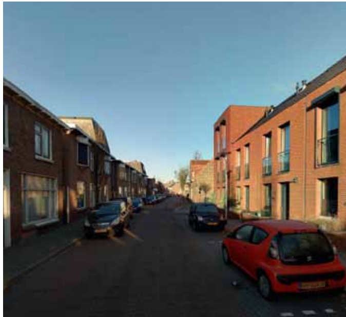
2. Nieuwe eengezinswoningen Goed Wonen fase 1 aan de Hofstraat
