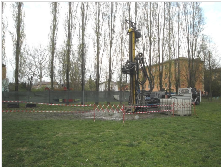
Foto 4.1 - Esecuzione del sondaggio a San Pietro in Casale
