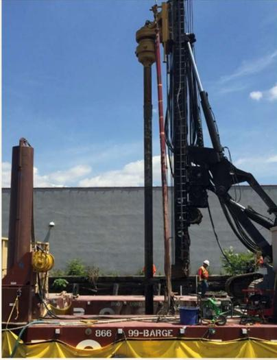
*Barrena mezclando cemento con el sedimento nativo contaminado durante la ISS piloto en la dársena de maniobras de 7<sup>th</sup> Street (realizado en*
