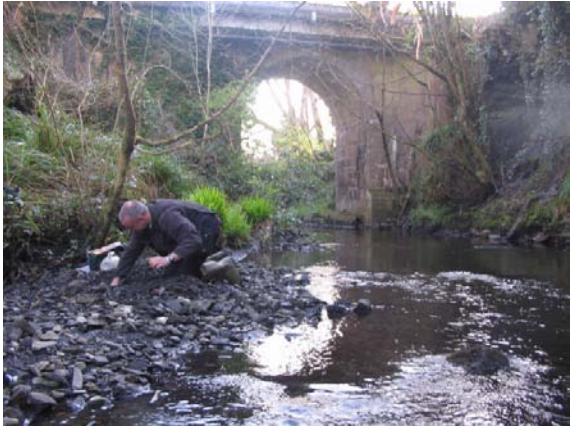
Plate 6.7. Aille River, Lisdoonvarna bridge, Co. Clare (CL6).
