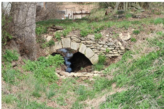
Obr. 4.10 Bod 9 - Plechtinec, relikv kanálu s obloukovým mostkem
