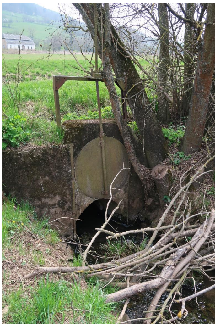
Obr. 4.9 Bod 8 - Plechtinec, nátok do Jevíčky se stavidlem
