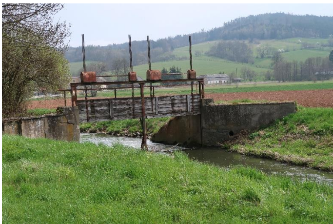
Obr. 4.7 Bod 6 - Petrůvka, stavidla na Třebůvce, odbočka na kanál
