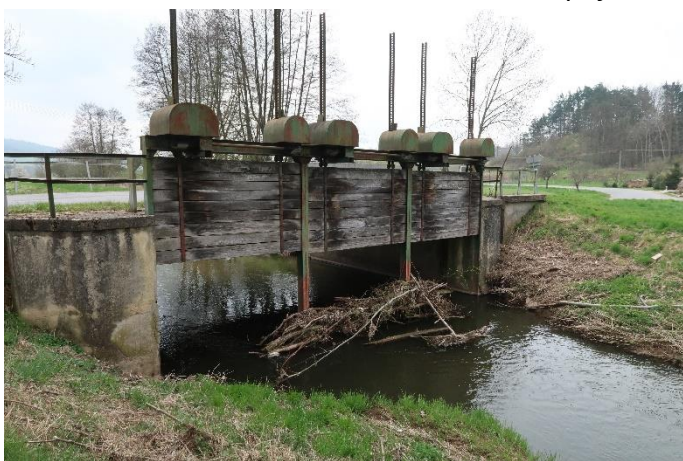
Obr. 4.3 Bod 2 - Mezihoří, začátek kanálu, křížení s komunikací, stavidla
