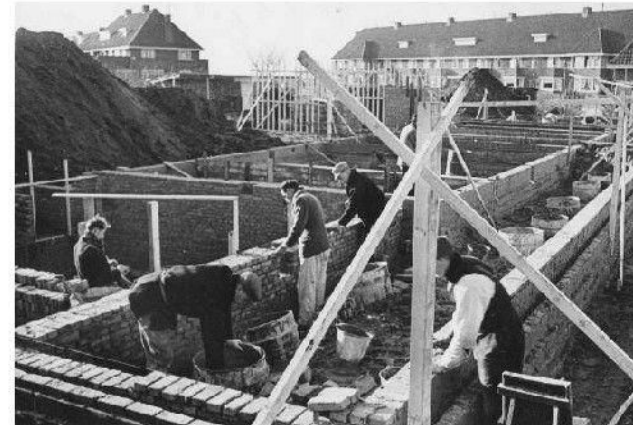
Bouw van de Hoeksteen (1950-1951)
