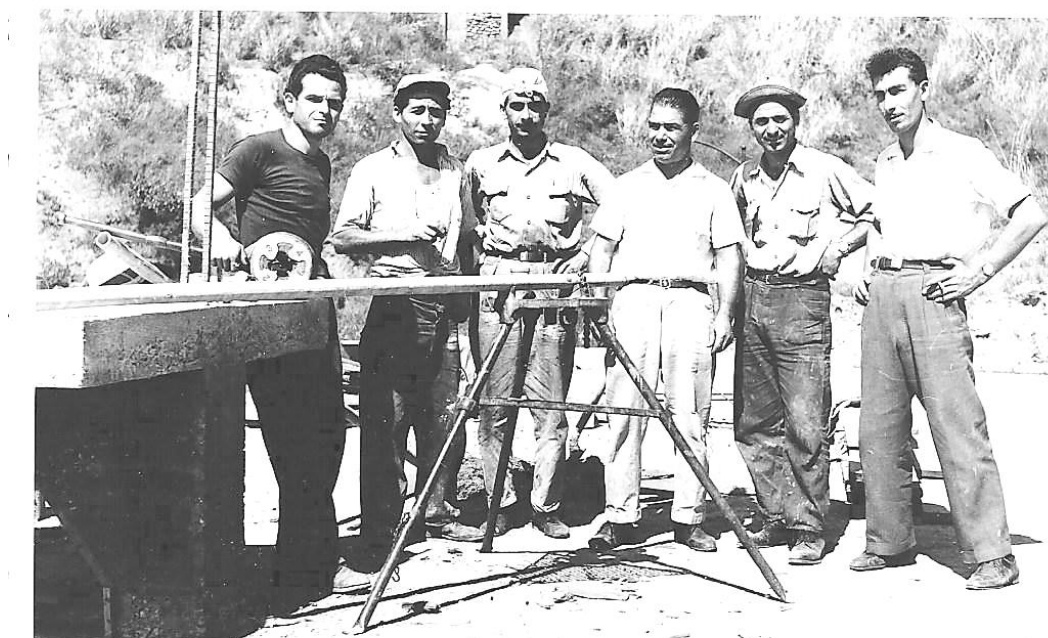
Sebastiano Di Bucci con cinque operai in un cantiere in Venezuela
