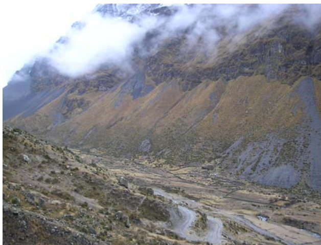
Figura 2.1.4 - 12: Vista de conos de talud
