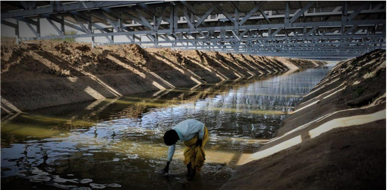
Εικ.Δ11.2.1.8: Τοποθέτηση ηλιακών πάνελ στα κανάλια της περιοχής Βαντοντάρα, Ινδία.
