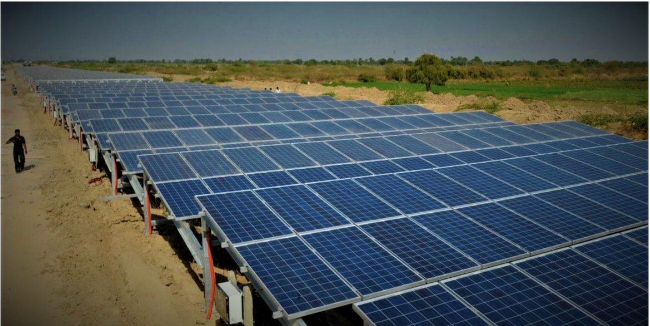
Εικ.Δ11.2.1.9: Τοποθέτηση ηλιακών πάνελ στα κανάλια της περιοχής Βαντοντάρα, Ινδία.
