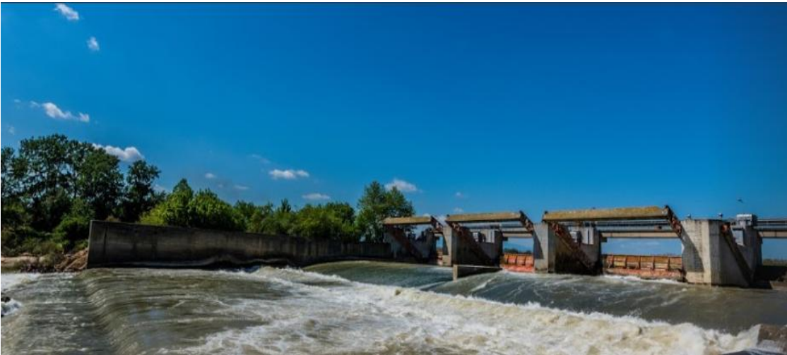
Εικ.Δ7.3.3: Το φράγμα της Ελεούσας από την κατόντη πλευρά, όπου φαίνονται τα θυροφράγματα (Google Earth).
