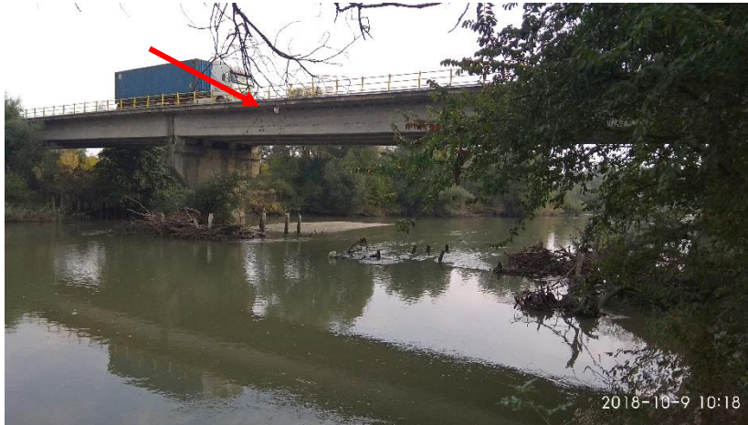
Σχήμα 3.4: Γέφυρα Νησελίου – Μετρήσεις RQ30
