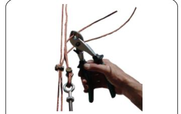
Nach kompletter Überhöhung und Feineinstellung können die Hängerseile gekürzt werden.
