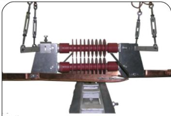
Überprüfen Sie die Kufenlaufeigenschaften mit einem Stromabnehmer oder Wasserwaage.
