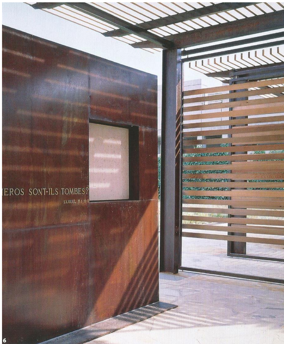
Figura 21. Uno de los paneles de acero con el nicho donde se halla la losa de piedra grabada.
