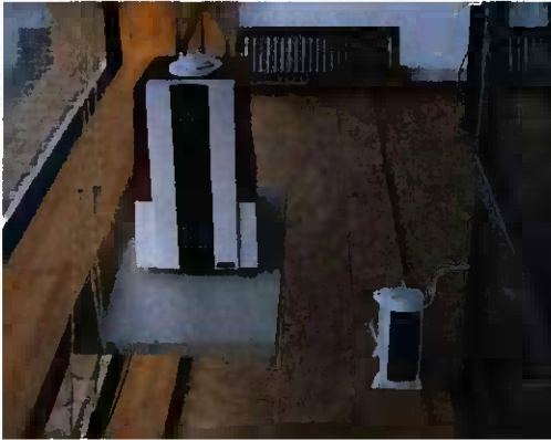
Abb. 79 Luftbefeuchter und Heizlüfter im Innenraum der Testfassade
