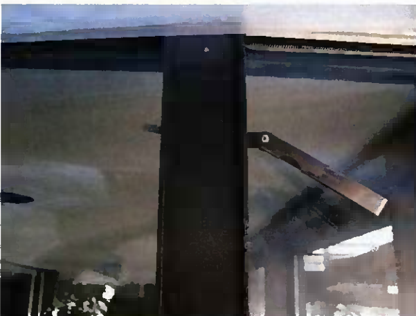
Abb. 5 Beispiel einer nicht ausreichenden Druckprofilverschraubung
