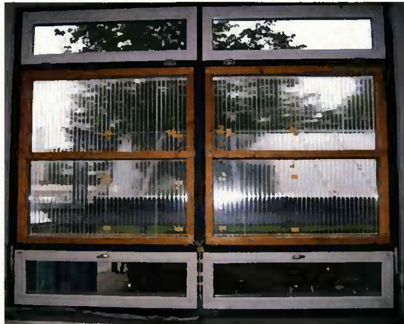
Abb. 23 Innenansicht in der Testelemente in der FH-Fassade
