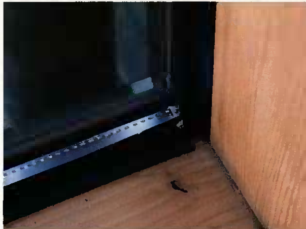
Abb. 3 Beispiel einer offenen raumseitigen Dichtungsecke
