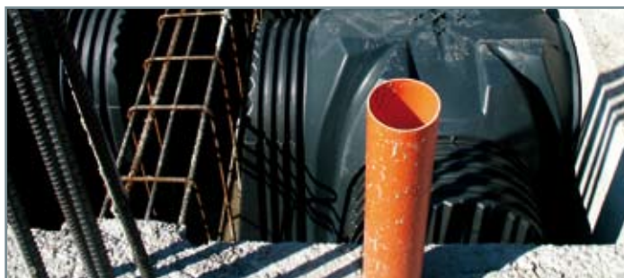
Esempio di realizzazione di fondazione ventilata con sottofondazione.
