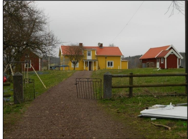
House at Övrabo
