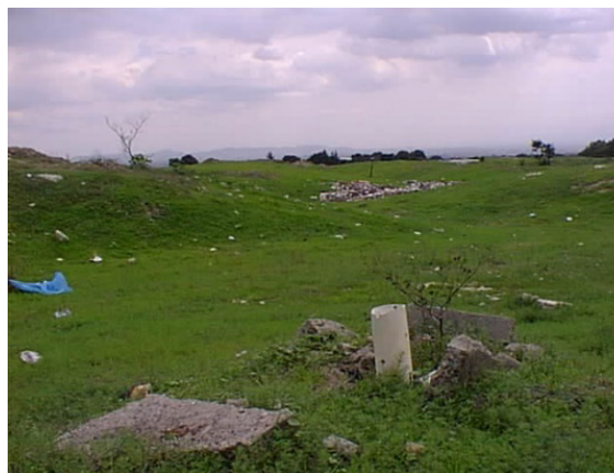
Figura 25. Sitio Resurrección I, tubos de venteo y asentamientos en la zona. Elaboración propia tomada de archivo personal.
