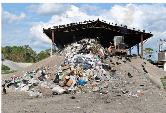
Figura 2. Planta de Biorgánicos del Sur, antes de la ejecución del proyecto.
