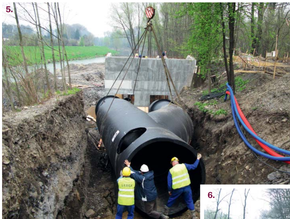
Fot. 5. Instalacja kształtki specjalnej tzw. „portek”
