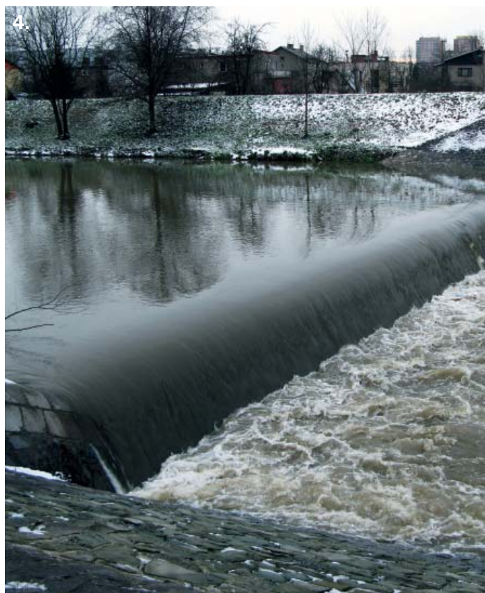
Fot. 2, 3. Instalacja rurociągu derywacyjnego Fot. 4. Jaz na rzece Olzie
