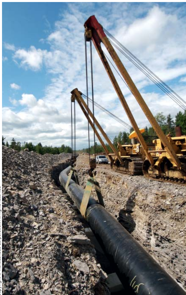
Fot. 2. Budowa gazociągu wysokiego ciśnienia w prowincji Ontario (Kanada)
