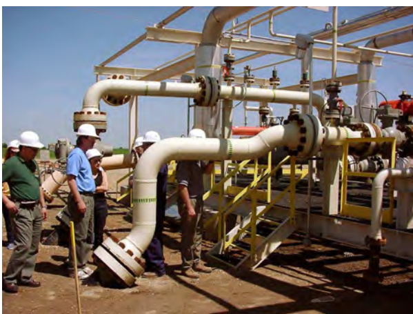
Fig. I.13 Sistema di iniezione della CO 2 all'interno del campo di Weyburn
