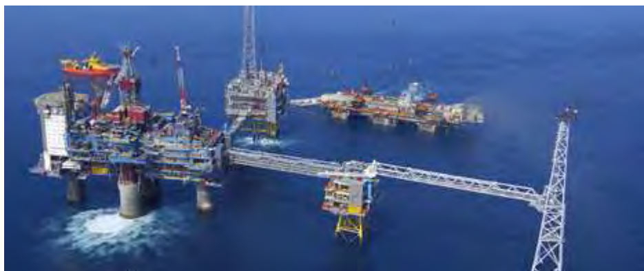
Fig. I.11 Vista aerea dell'impianto di Sleipner
