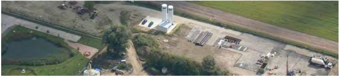
Fig. I.15 Panoramica dell'impianto di stoccaggio di Ketzin
