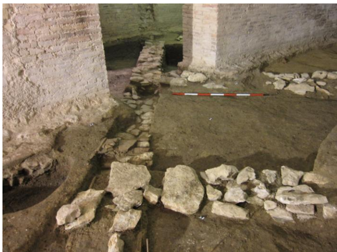
Fig. 35. Secondo periodo romano: ultimi interventi nell'edificio di età romana, con la realizzazione di murature in blocchi di gesso (USM 30 e 76).
