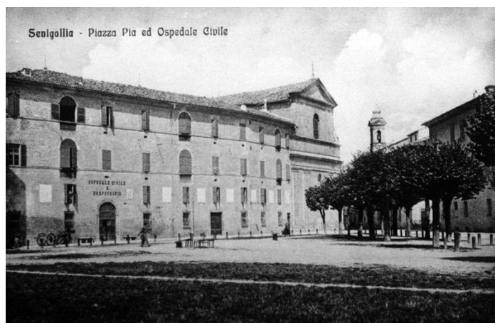
Fig. 40. Foto storica dello Stabilimento Pio e della Chiesa della Maddalena.
