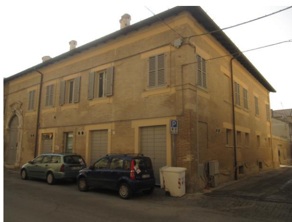
Fig. 2. Lo stabile settecentesco nelle cui cantine sono state effettuate le indagini archeologiche.
