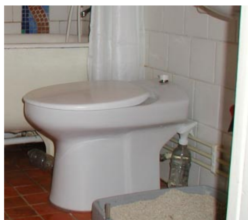
Toilet at Gebers
