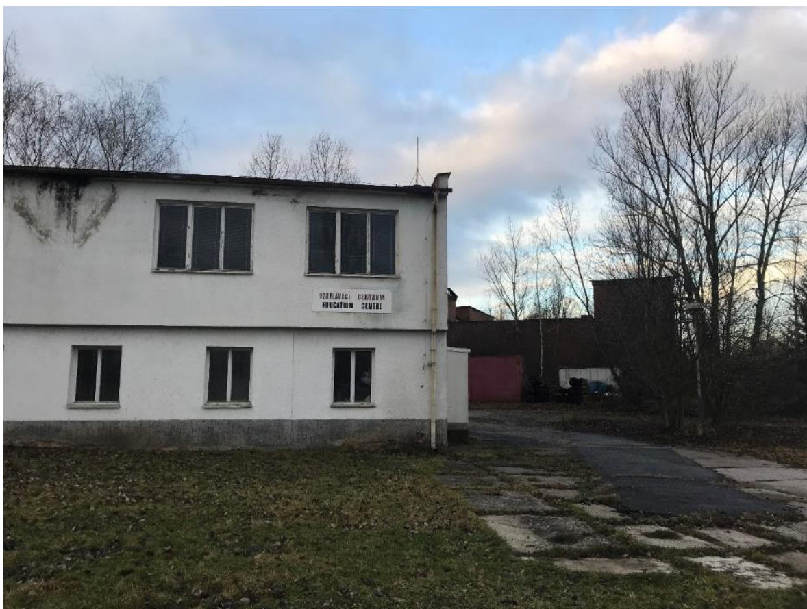
Obr. č. 1 - 3 – areál AVIA Letňany, teplovod, komunikace vně areálu, opuštěné kancelářské budovy zdroj: foto autorka 10.1.2020
